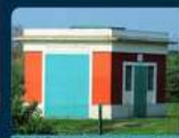
Poste de pompage d'eau de Louveciennes (Jean-Louis Pons)
