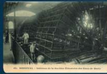
12. BODDVAUX - Intérieur de la Machine de Marly
