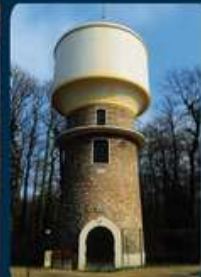
Réservoir d'eau de Louveciennes (Jean-Louis Pons)
