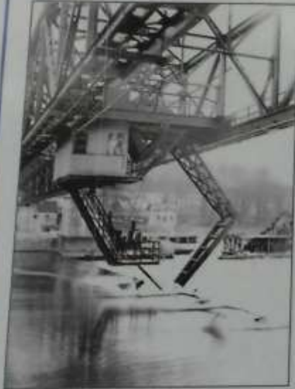
Chariot de manœuvre en action sur une hausse
